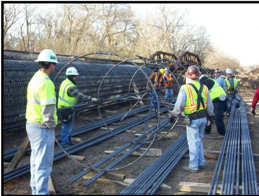
Rebar Cage Fabrication
